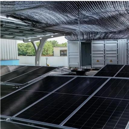
[200kW Off Grid solar system \(230.4kWh\)](#)
